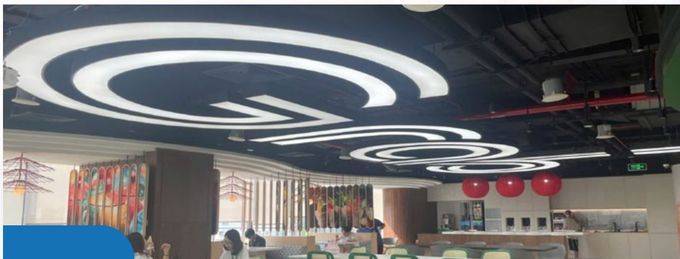
Dự án Thi công đèn xuyên sáng tạo chữ được thi công cho văn phòng GRAB Illuminated Lettering Ceiling Installation for the GRAB Office
