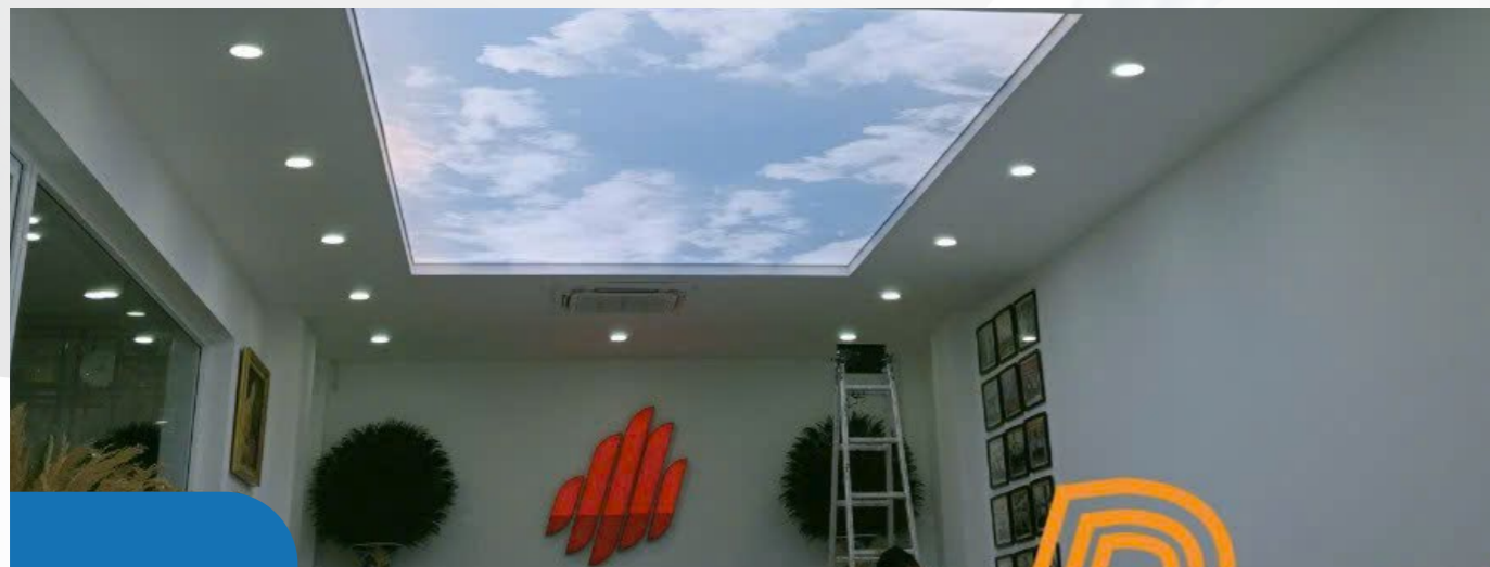
Trần Xuyên Sáng bầu trời thi công cho không gian văn phòng công ty Gạch Đồng Tâm Sky-themed Stretch Ceiling Installation for the Office Space of Dong Tam Tile Company
