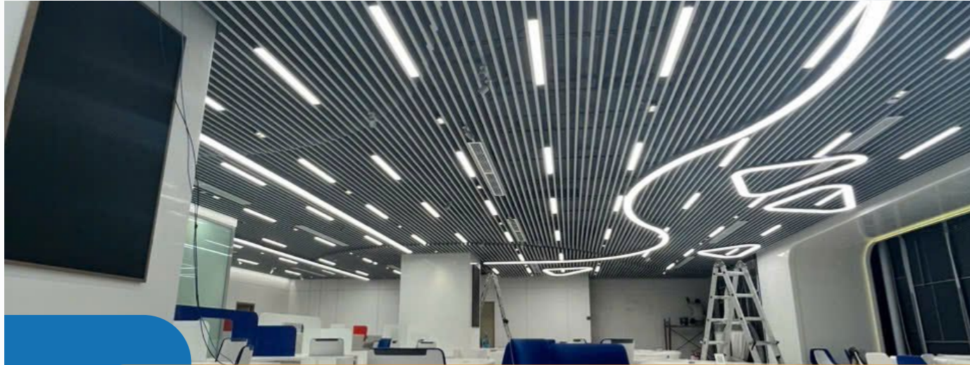
Dự án Đèn xuyên sáng thi công tại Hội Sở Ngân Hàng SACOMBANK - TPHCM Illuminated Ceiling Installation at the SACOMBANK Headquarters - Ho Chi Minh City
