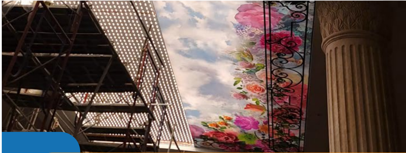
Trần Xuyên Sáng In Họa Tiết Công Trình Sảnh Ros - Bà nà hill cho tập đoàn Sun Group Printed Stretch Ceiling Installation for the Ros Lobby - Ba Na Hills, Sun Group
